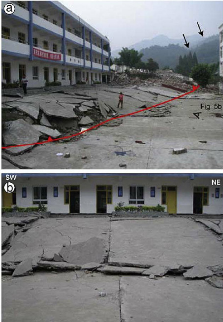
شکل ۷. زون گسیختگی سطحی روی گسل پنگوان در شهر بایلوچین در زلزله ونچوان ۲۰۰۸ [۳۰]
